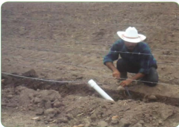
Foto 79. Finales de tubería para Limpieza.
