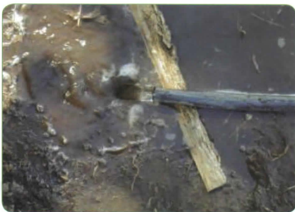
Foto 78. Limpieza de Cinta de Goteo
