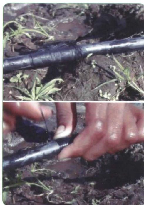
Foto 85 y 86. Reparación de fugas utilizando neumático de bicicleta o moto.
