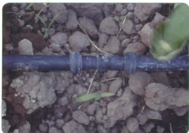
Foto 84. Reparación de fuga usando un conector de cinta a cinta.
